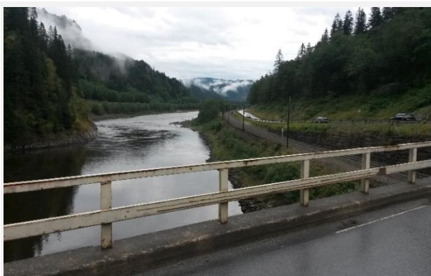
Figur 4-5 Fra Håggåbrua, sett sørøver mot Støren (aug 2016).
